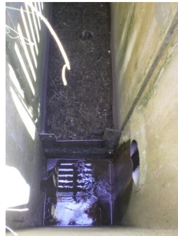
Arrivée en sortie du canal de mesure de l'ancienne station
